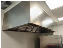
Referencia: CPM-037 CAMPANA EXTRACTORA Año: . Marca: .
