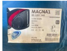
Referencia: LFR-098 BOMBA IMPULSORA Año: . Marca: GRUNDFOS
